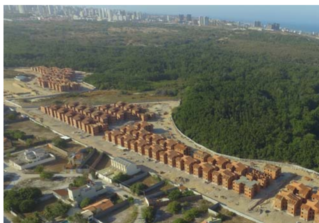
Figura 2 - Obra do Residencial Dendê
