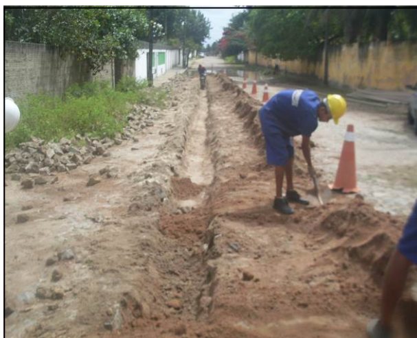
Figura 16 - Execução da Rede de Distribuição PVC 50mm e posterior reaterro
