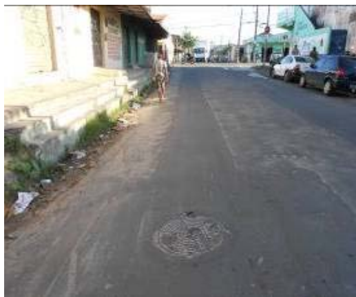
Figura 24 – Poços de Visitas - PVs e Pavimentação Recuperada no Bairro Bom Jardim
