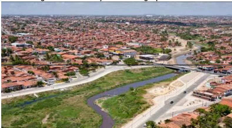
Figura 15 - Urbanização Rio Maranguapinho Trecho I
