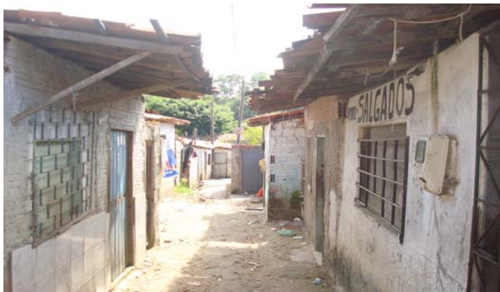
Figura 4 – Situação atual da área da Comunidade do Dendê
