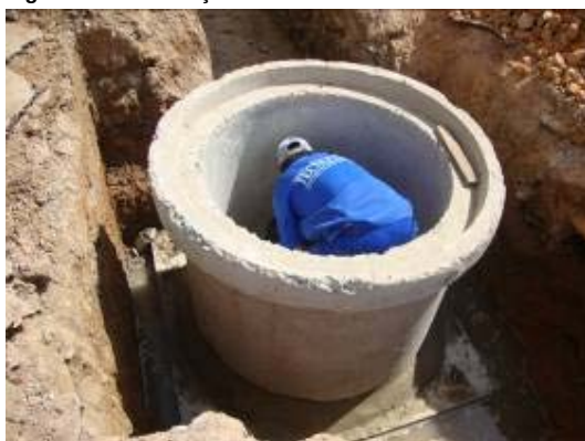
Figura 25 - Colocação de PV na Avenida São Cristóvão.
