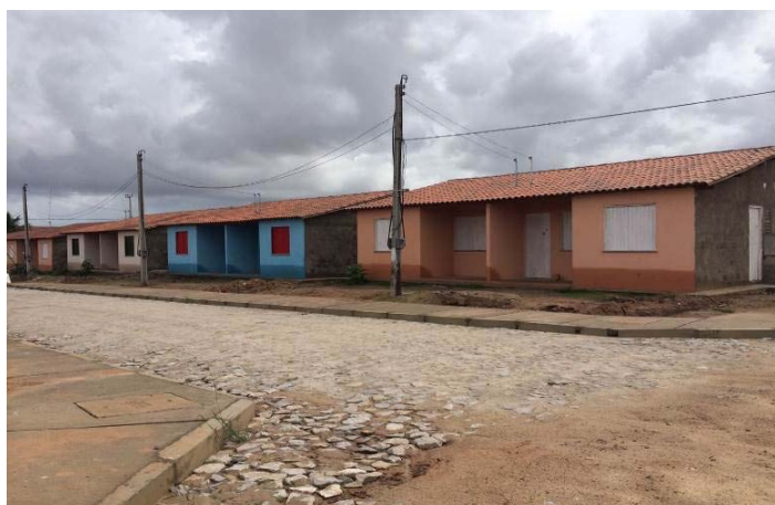
Figura 1 - Obra do Residencial Aldemir Martins
