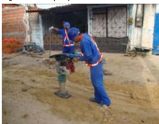
Figura 26 - Recuperação de Pavimento na Rua 115.
