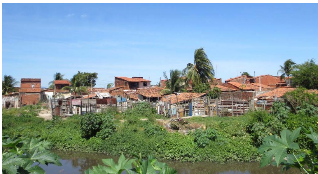
Área desapropriada e obras de urbanização - Trecho II
