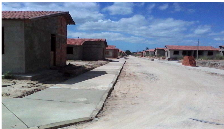
Obra do Residencial Aldemir Martins
