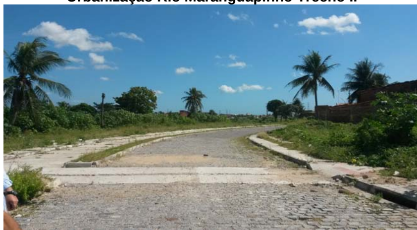
Urbanização Rio Maranguapinho Trecho II
