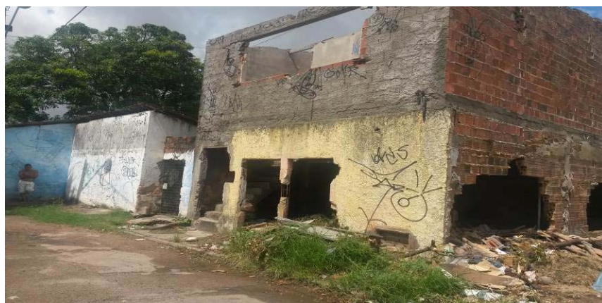
Figura 16 - Imóvel Indenizado Trecho III
