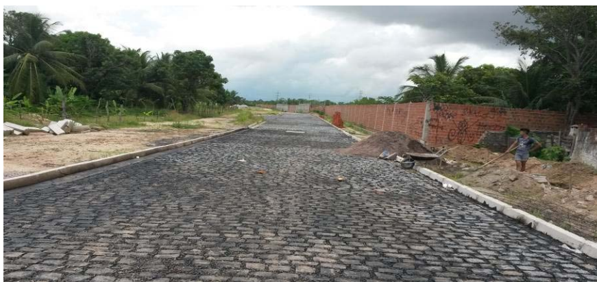
Figura 15 - Urbanização Rio Maranguapinho Trecho III
