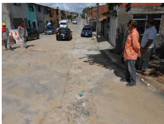
Figura 25 - Rede coletora de Esgoto
