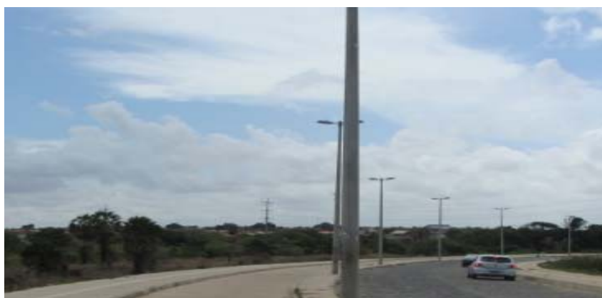
Figura 13 - Urbanização Rio Maranguapinho Trecho I
