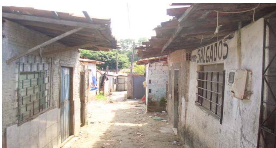
Figura 6 – Situação atual da área da Comunidade do Dendê
