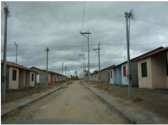
Figura 1 - Obra do Residencial Aldemir Martins
