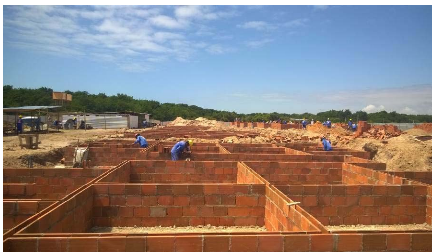
Figura 7 - Obra do Residencial Dêndê
