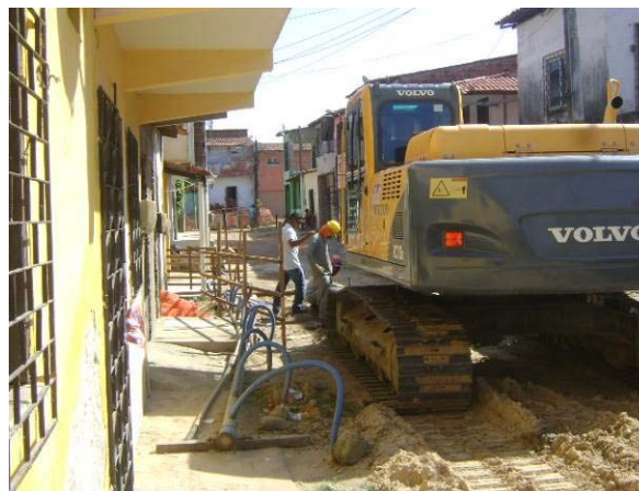
Figura 24 - Rebaixamento Lençol Rede Coletora
