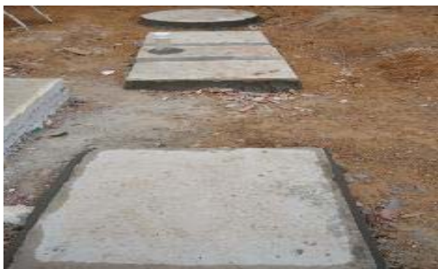
Figura 10 - Caixa de inspeção, fossa séptica e sumidouro
