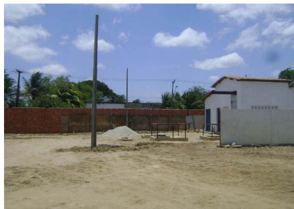
Figura 22 - Estação Elevatória de Esgoto
