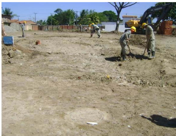
Figura 23 - Estação Elevatória de Esgoto
