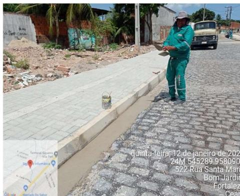
**Foto 2** – Construção de sarjeta na via paisagística do Trecho II Margem Esquerda em Jan/2023.
